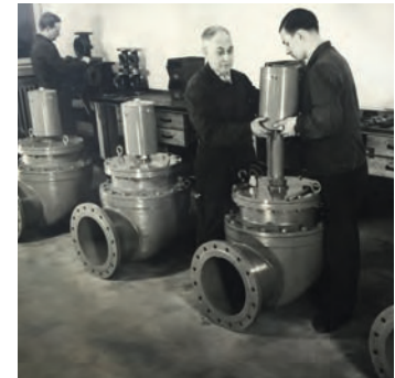
Im Jahr 1961 wurden Sonderventile der alten Baureihe 1000 für die Rohrpostanlage des Hamburger Hauptpostamtes gefertigt.
